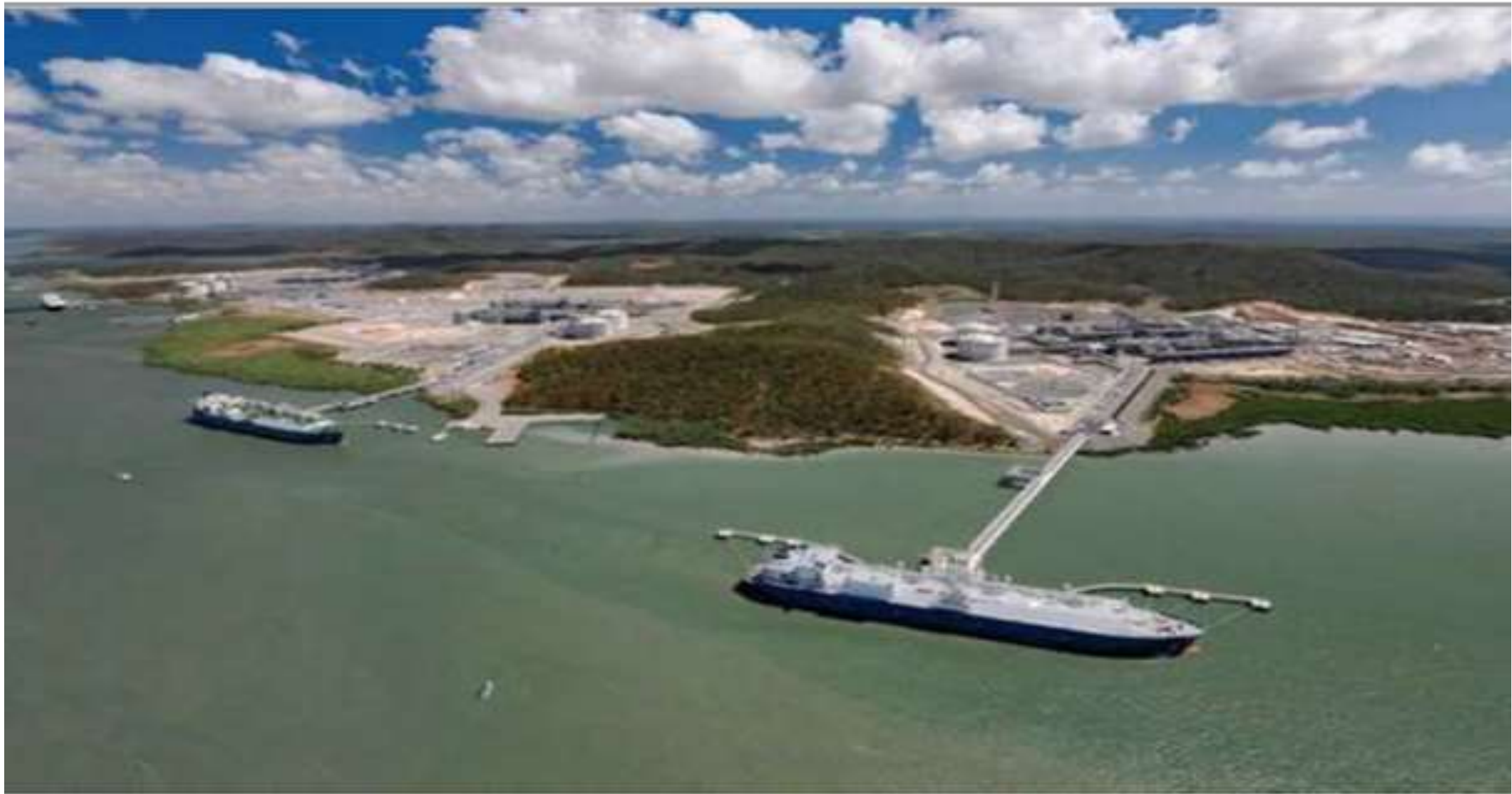
Εικόνα 28. Φόρτωσης υγροποιημένου φυσικού αερίου σε LNG πλοία απο την νήσο Γαύδο.
